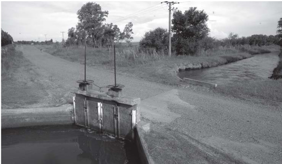
Canalización de Calagua
