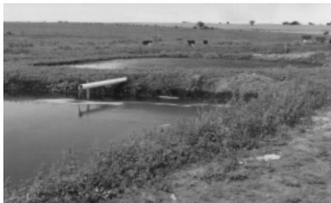
Sistemas de piletas de oxidación para el tratamiento de efluentes de tambo (Canelones)
