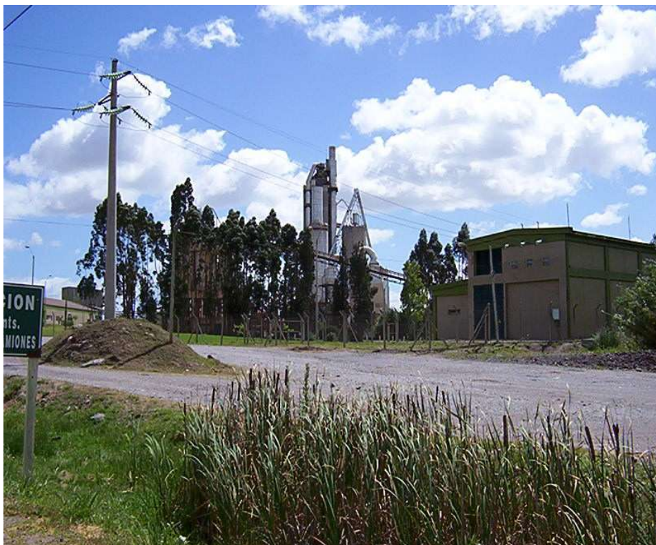
Imagen 2: Planta de cemento de CUCPSA
