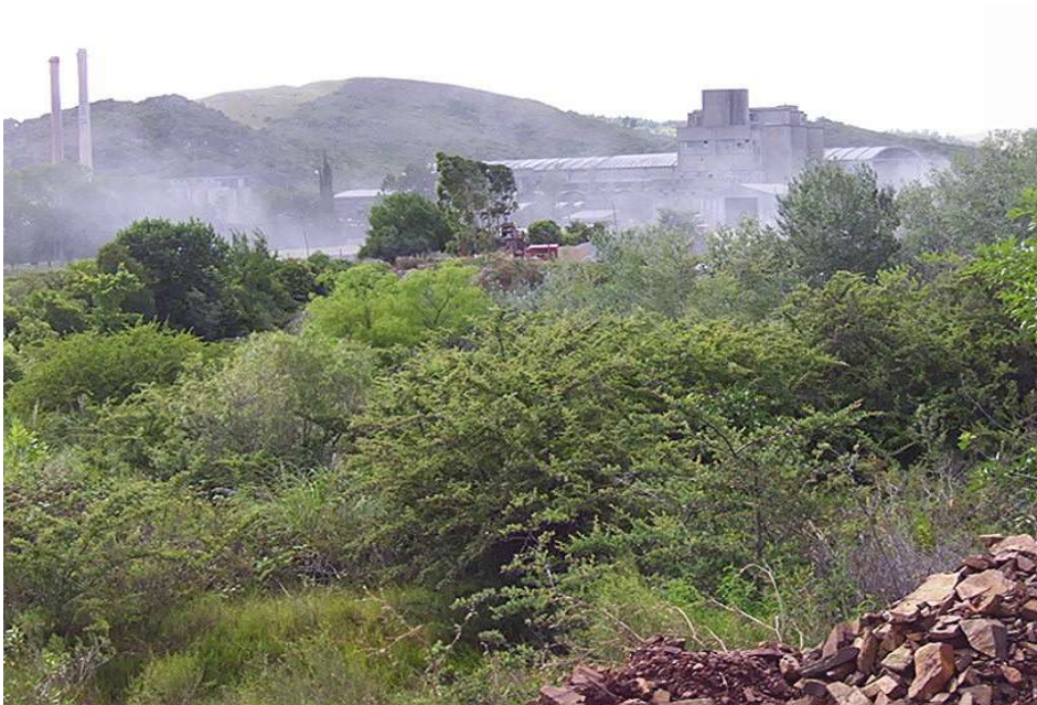
Imagen 1: planta de cemento de ANCAP
